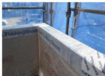
2015年4月から新たに発売された透湿系水切りシート タイベック®フラッシングシート及び伸張性防水角部材 ストレッチガード®を含めたフラッシングシステム(外壁防水システム)について、実際の構造模型にて施工しながら解説します。従来の施工方法も実演しながらどこに雨漏りリスクが潜んでいるのかを解説致します。
