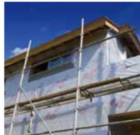
タイベック、シルバーは、強靱な不織布であるデュポン™ タイベック® にアルミニウムを蒸着し、「湿気を逃がして防水する」機能に加え、夏涼しく冬暖かく室内を快適に保つ「遮熱」機能を持たせた、透湿・防水・遮熱シートです。また劣化を抑える抗酸化樹脂コーティングで更なる耐久性を実現し、長期にわたり住まいを守ります。
