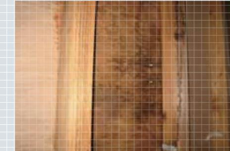
夏は、温度勾配によって、湿気は室内側へ移動する傾向がありますが、通常の防湿気密シート(PEシート)が施工されている場合、断熱材とPEシート間の湿度は、極めて高くなる恐れがあります。とりわけ新築直後の構造体や基礎コンクリートから放出される湿気は多く、壁体内の湿度は高くなり、リスクは更に高まります。
