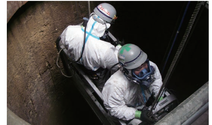
ダイオキシン含有灰の掻き落し作業
